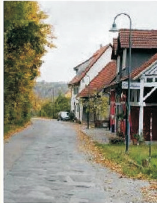
Bald rücken in der Sennenfelder Straße die Bagger an. Foto: Agentur Kochertal
